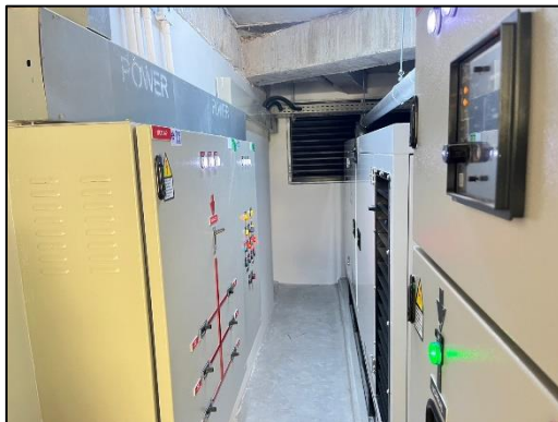
รูปที่ 11 ระบบมิเตอร์ไฟฟ้าสำหรับระบบบำบัดน้ำเสีย
