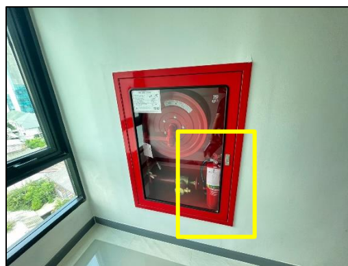
รูปที่ 27 ถังดับเพลิงมือถือ ขนาด 10 ปอนด์/ถังดับเพลิงมือถือแบบผงเคมีแห้ง
