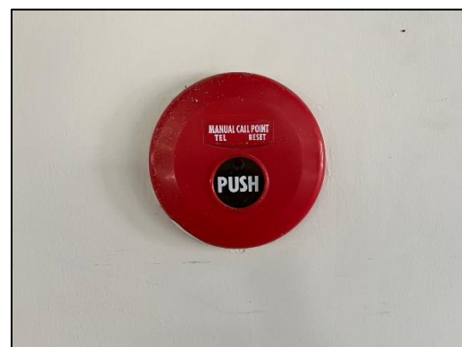
รูปที่ 28 เครื่องตรวจจับควัน /เครื่องตรวจจับแก๊สรั่ว /เครื่องแจ้งเหตุโดยใช้มือตึง /กริ่งสัญญาณเตือนภัย
