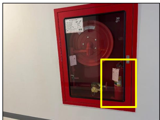
รูปที่ 27 ถังดับเพลิงมือถือ ขนาด 10 ปอนด์/ถังดับเพลิงมือถือแบบผงเคมีแห้ง
