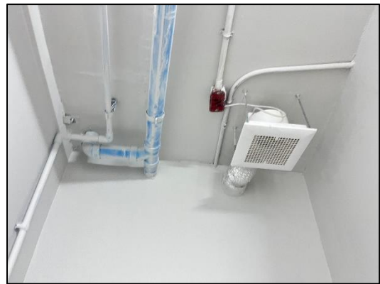
รูปที่ 18 ท่อระบายอากาศของบ่อบำบัดก๊าซมีเทน
