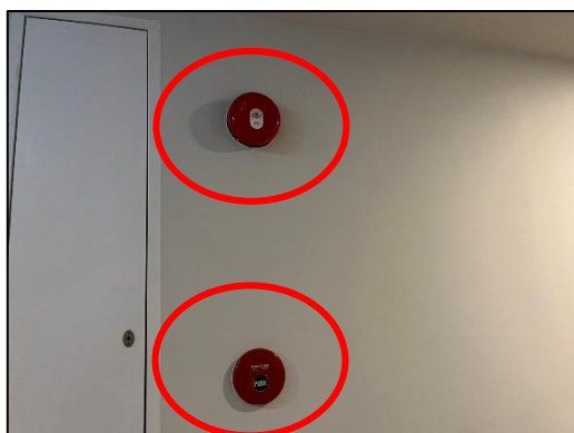
รูปที่ 28 เครื่องตรวจจับควัน /เครื่องตรวจจับแก๊สรั่ว /เครื่องแจ้งเหตุโดยใช้มือตึง /กริ่งสัญญาณเตือนภัย
