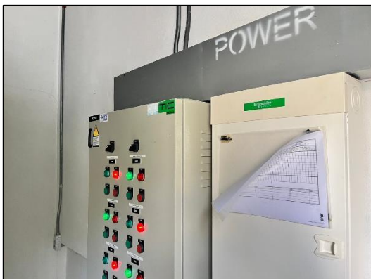
รูปที่ 20 อุปกรณ์หลักสำหรับระบบจ่ายไฟฟ้า/บันทึกการตรวจสอบระบบไฟฟ้า (MDB)
