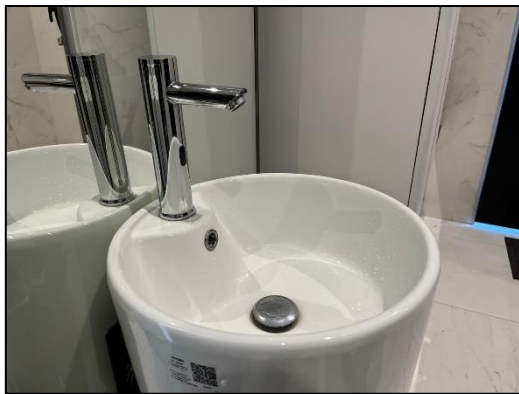
รูปที่ 13 สุขภัณฑ์ที่ประหยัดน้ำหรืออุปกรณ์ที่มีประหยัดน้ำ
